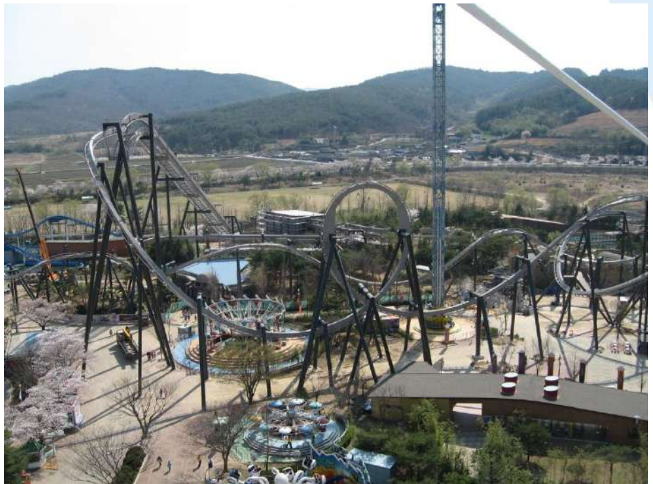
롤러코스터 설치공사 (경주월드)
