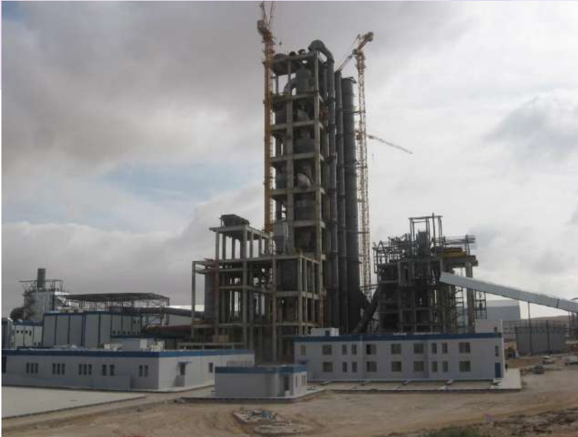
Cement Plant 기계설치공사(중동 Jordan)
