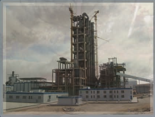
Cement Plant 기계설치공사(중동 Jordan)
